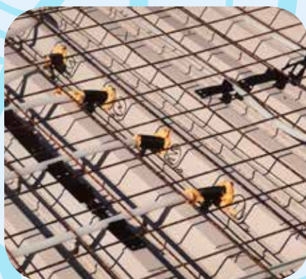
“Eksempel på tilleggsarmering og vannbåren varme”
