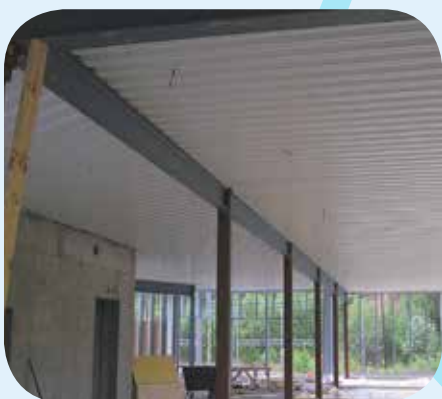
“Underside av dekke”
