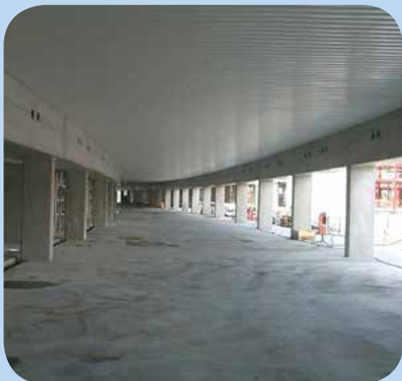
“Underside parkeringshus på Fornebu (totalt 40.000 m 2 PEVA®45)”
